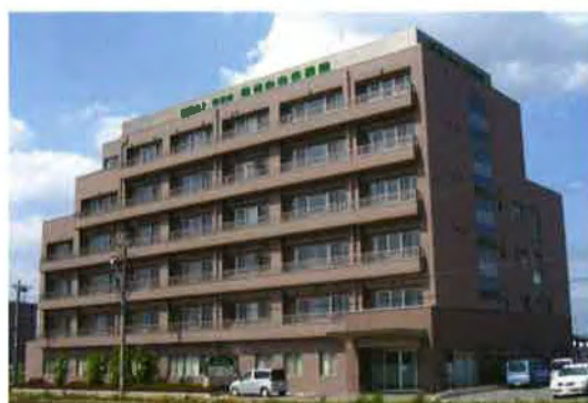
寿光会中央病院全景
