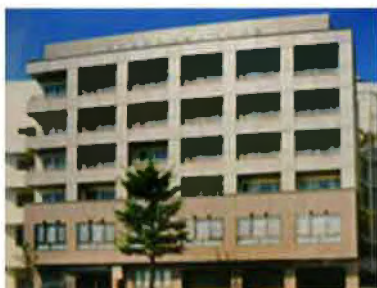
横浜磯子介護老人保健施設全景
