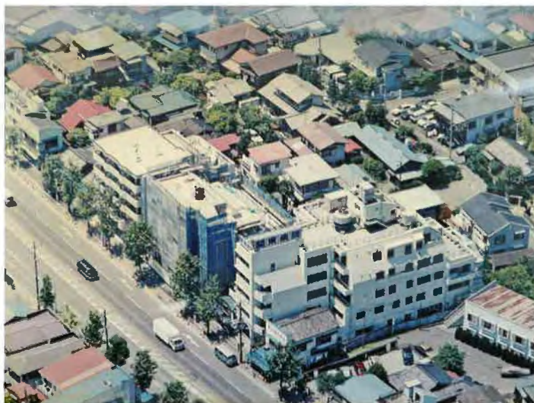
(旧) 関東病院新築当時
