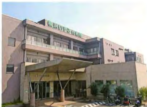
増築後の正面外観
